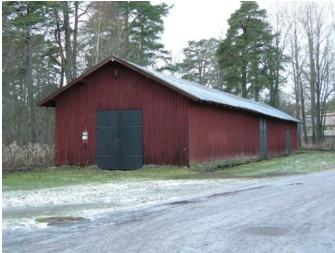
Ladan sedd från sydost. Exteriören är en värdebärare i sin helhet. Foto Läns museet Gävleborg 2008-01-11.
