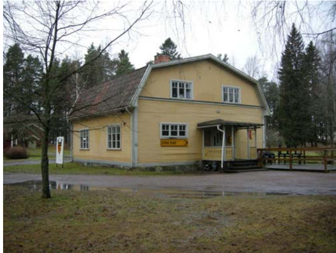
Lilla Vall sedd från sydost. Fasaderna med panel och snickeridetalj, fönstrens form, takmaterialet och verandan är värdebärare. Foto Läns museet Gävleborg 2008-01-11.
