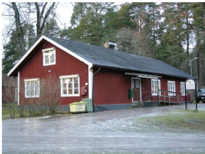
Fd Hemvärnskontoret sett från sydost. Fasadernas uppbyggnad, panel och färgsättning, fönstrens form, takets form och material samt entrépartiet är värdebärare. Foto Länsmuseet Gävleborg 2008-01-10.
