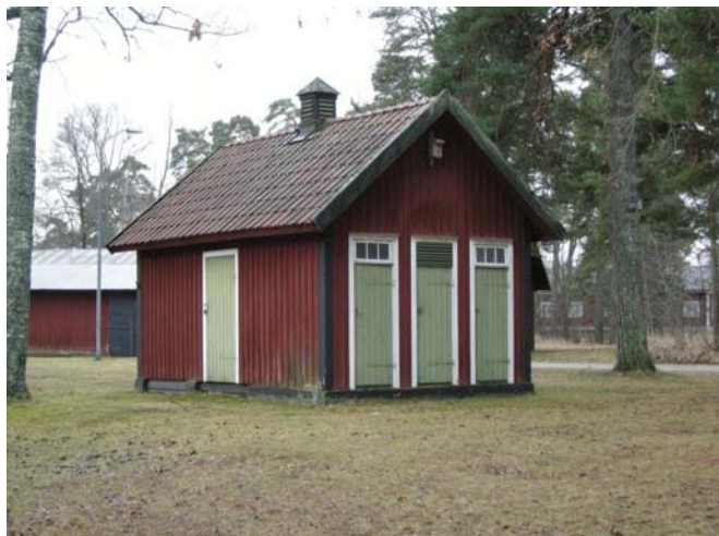
Det lilla uthuset sett från nordost. Exteriören i sin helhet utgör en värdebärare. Foto Läns museet Gävleborg 2008-01-10
