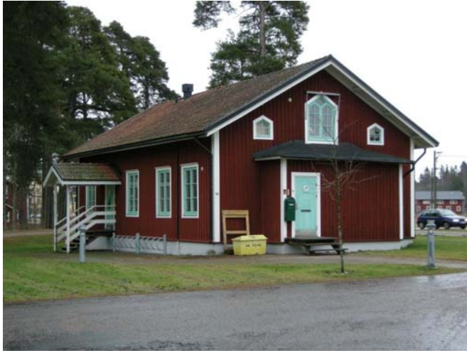
Nybygget sett från väster. Fasadernas uppbyggnad och material, takets form och material och fönstrens form är värdebärande. Foto Läns museet Gävleborg 2008-01-14.
