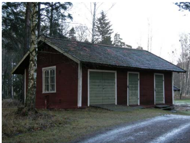
Lilla Valls uthus sett från sydväst. Exteriören i sin helhet utgör en värdebärare.
