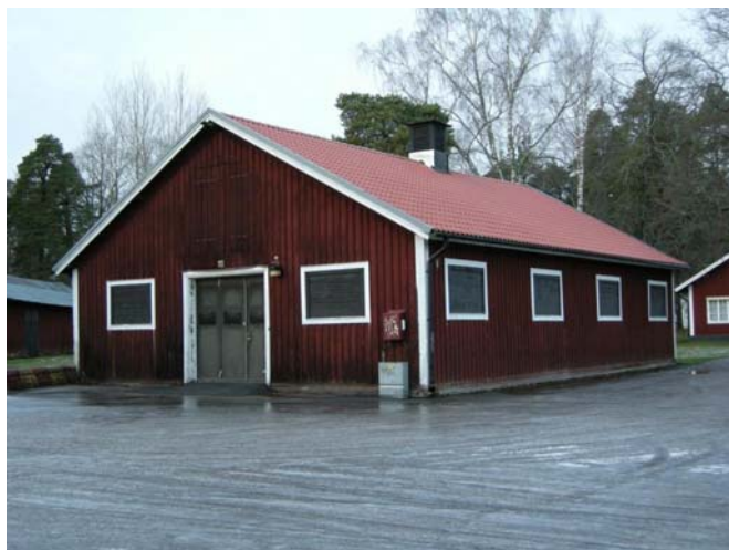
Vårdhallen (mc-garaget) sedd från sydost. Värdebärare är fasadernas uppbyggnad, material och färgsättning, fönstren (bortsett från luckorna), takets form och de krokförsedda bjälkarna vid gavelnocken. Foto Läns museet Gävleborg 2008-01-10.
