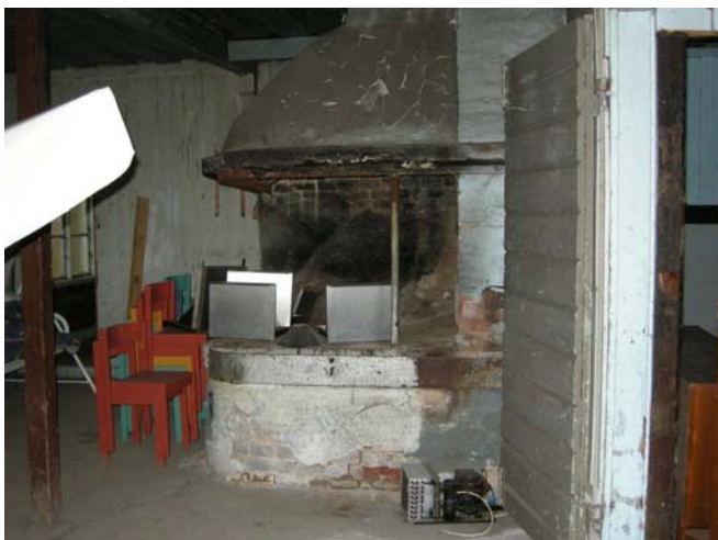
Härden i det stora rummet mot norr. Invändigt är härdarna, den bevarade ursprungliga planlösningen, trägolven, fönstren, och övriga ursprungliga snickerier och inredningar värdebärare.
